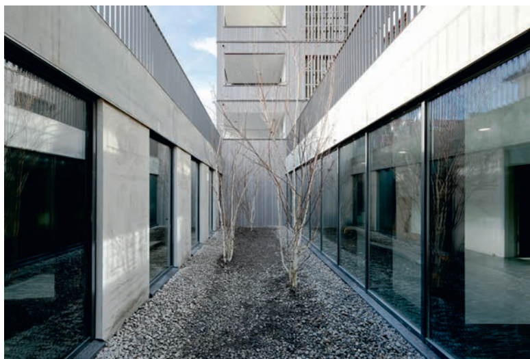
Der Lichthof verbindet die beiden Gebäudeteile und soll die Kommunikation zwischen den Bewohnern fördern.
