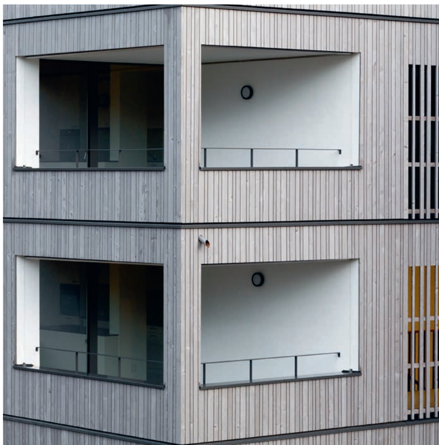
Die Fassade verlangte von den Zimmerleuten einen ausgeprägten Sinn für das Optische. Die Fassadenbretter laufen in drei verschiedenen Breiten jeweils über die gesamte Gebäudehöhe.
