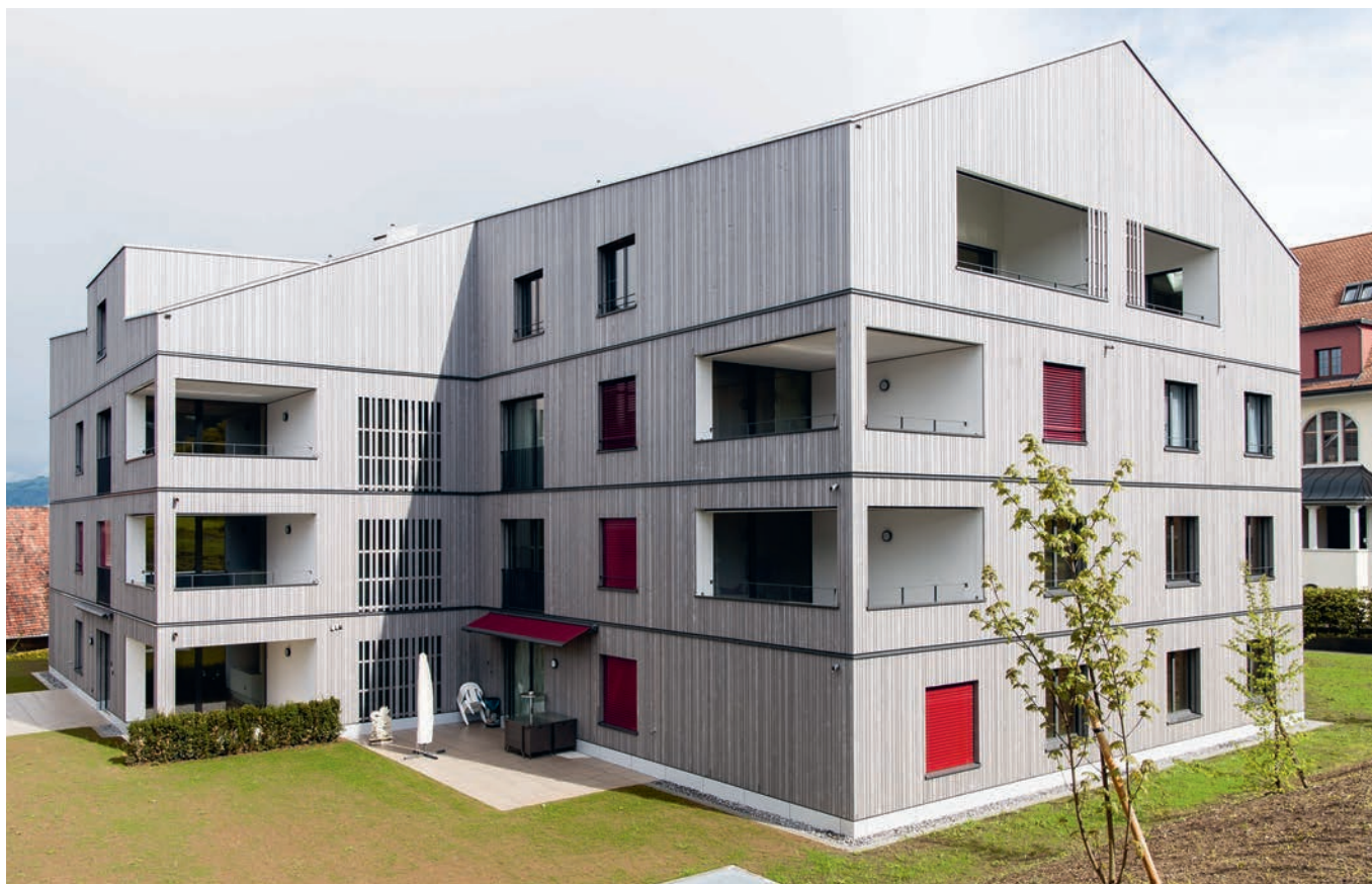
Das Gebäude mit seinen 16 Wohneinheiten ist fast ausschliesslich aus heimischem Fichten- und Tannenholz errichtet. Jede Wohnung verfügt über eine Loggia. Die Wand-, Decken- und Dachelemente wurden im Werk der Nussbaumer Holz AG in Baar gefertigt.
