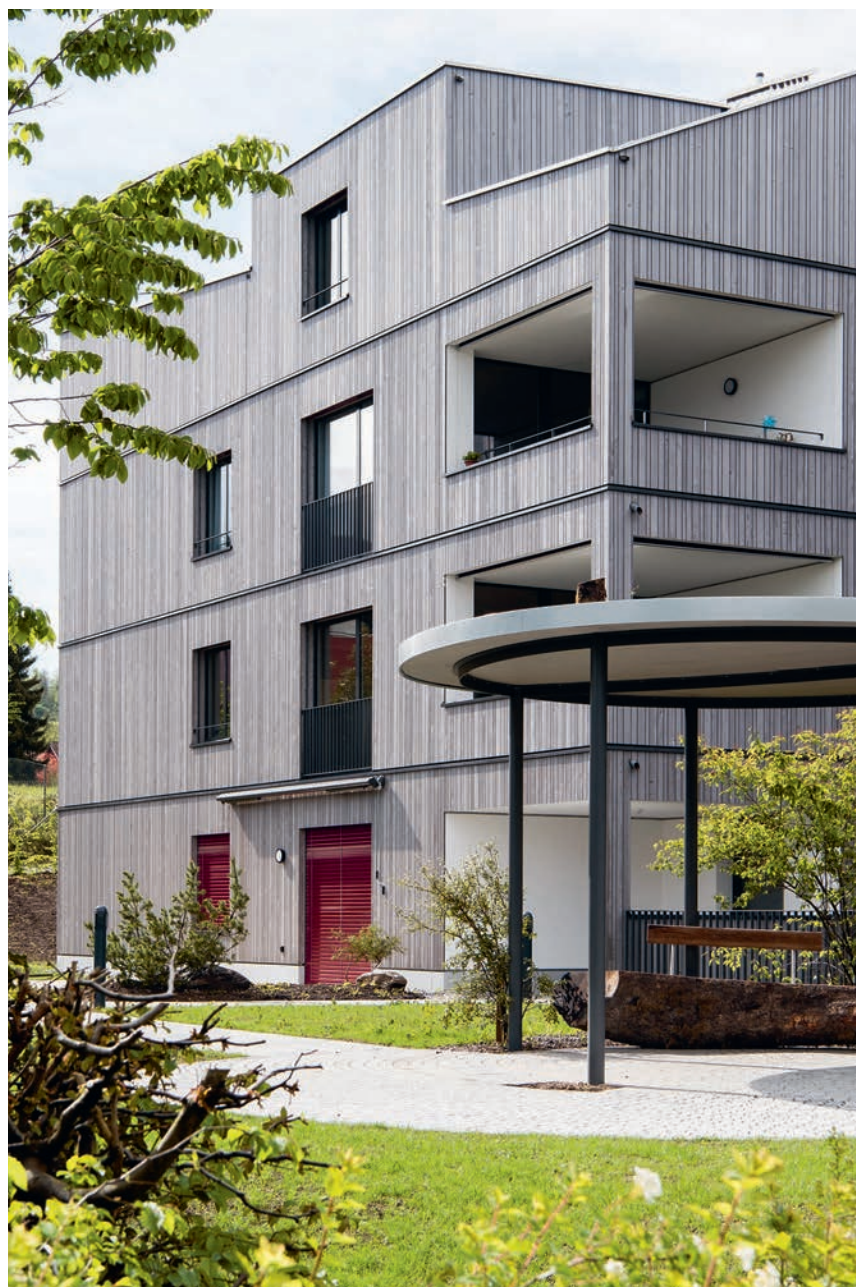
Das Mehrgenerationenwohnhaus in Dietwil ist zunächst als konventioneller Bau geplant und dann als Holzbau realisiert worden.
